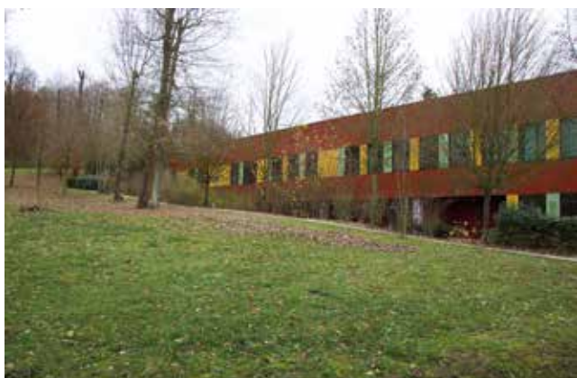
Lycée Samuel Beckett à La Ferté-sous-Jouarre (77)
